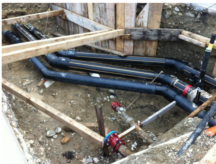
Avenue Châtelain à Rolle
