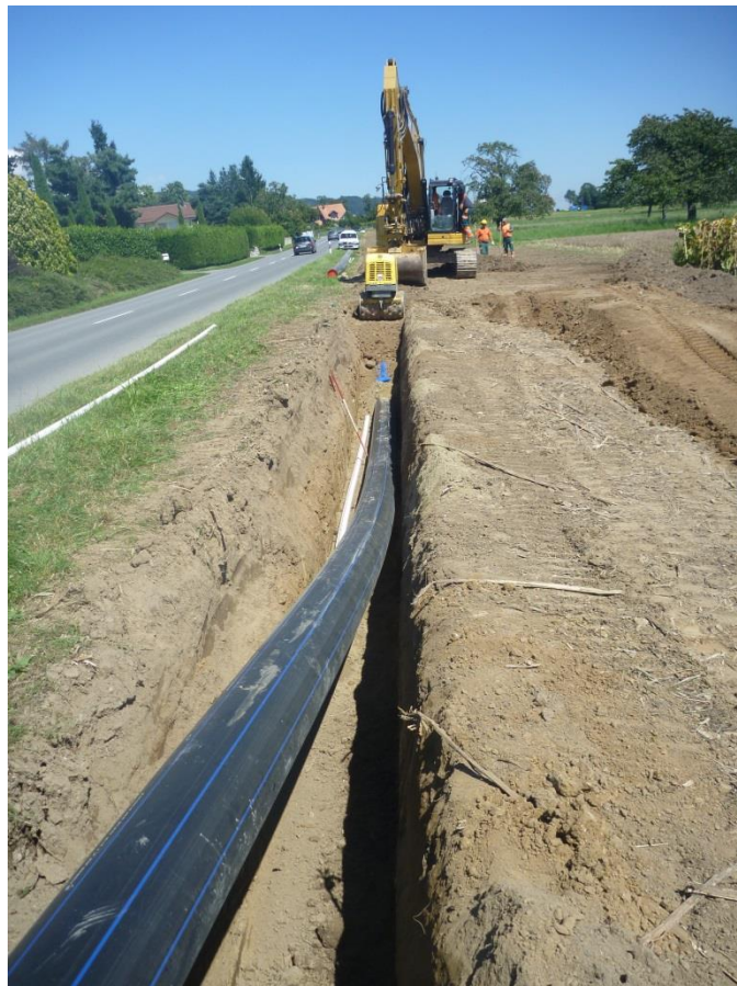
Construction de la conduite principale de l'Axe Ouest entre Luins et Champ Jaillet (Gilly)
